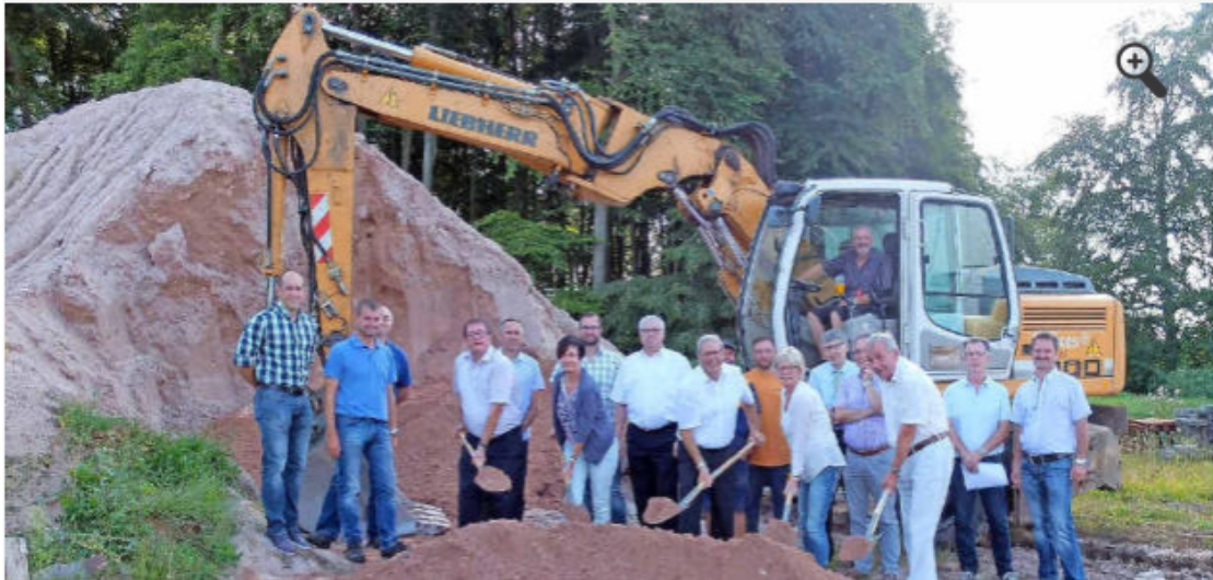
Etwa 350 000 Euro kostet die Erweiterung des Gewerbegebietes. Jetzt war Spatenstich. Foto: Gemeinde/ehü
